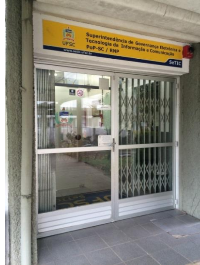
Figura 19 - Prédio SETIC/UFSC - Portão de entrada
