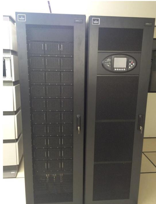
Figura 30 - UFSC - Nobreak Emerson (instalado em 150Kva Abril/2016)
