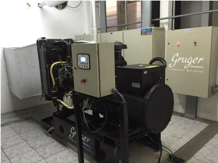
Figura 31 – UFSC Gerador 160 KVA (Instalado em Abril/2016)
