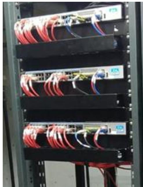
Figura 50 - Novos agregadores WAB implantado no rack 7.0, em detalhe( fig 8.24) (2020)
