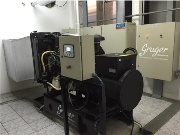
Figura 8.38 – UFSC Gerador 160 KVA (Instalado em Abril/2016)
